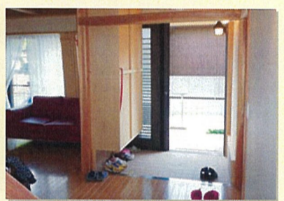
段差のない玄関・車いす利用者
